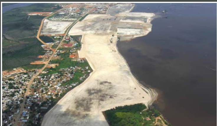
Site works for the Angola LNG Plant
