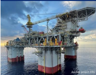
FPU - Floating production unit
